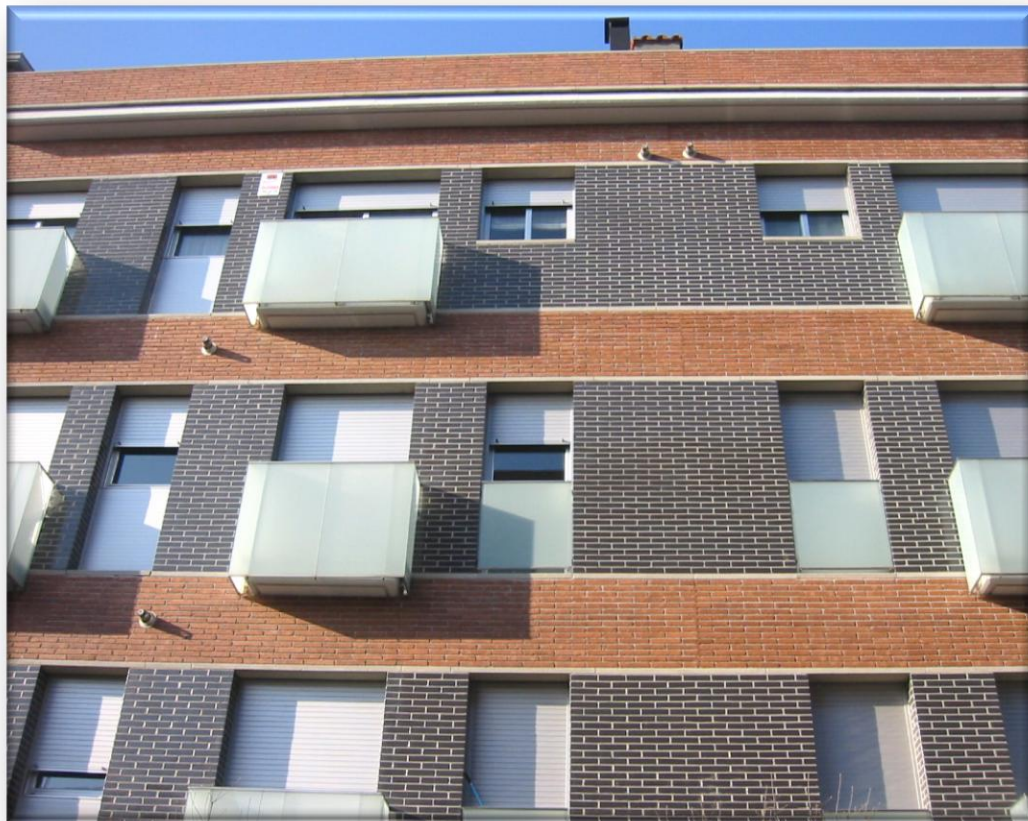
Façana realitzada amb dintell +tira entre dintell recte gris Abuxardat
