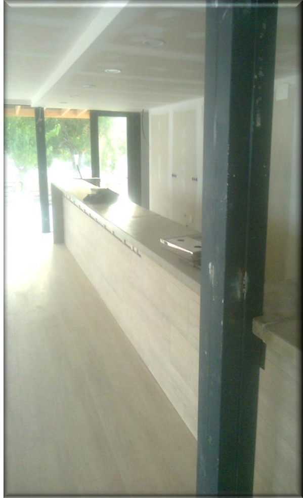
Barra de formigó durant el muntatge
